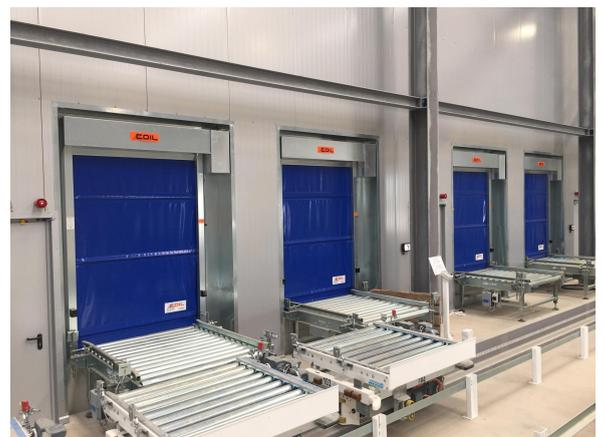
PAL 150 SP è una porta ad avvolgimento rapido verticale e nasce dall'esperienza COIL nel settore delle porte per ambienti ad alta sanitizzazione.
